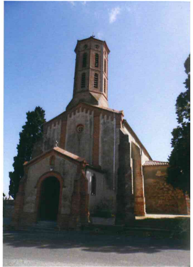
ÉGLISE, VUE DU SUD
